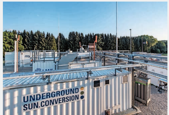
Fig. 1 Pilotanlage für Geomethanisierung in einer ausgeförderten Erdgaslagerstätte im österreichischen Pilsbach. (© RAG Austria AG)
