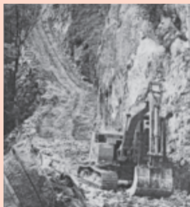
Der Bagger im felsigen Totenlauizug. Bild: Silvia Camenzind
