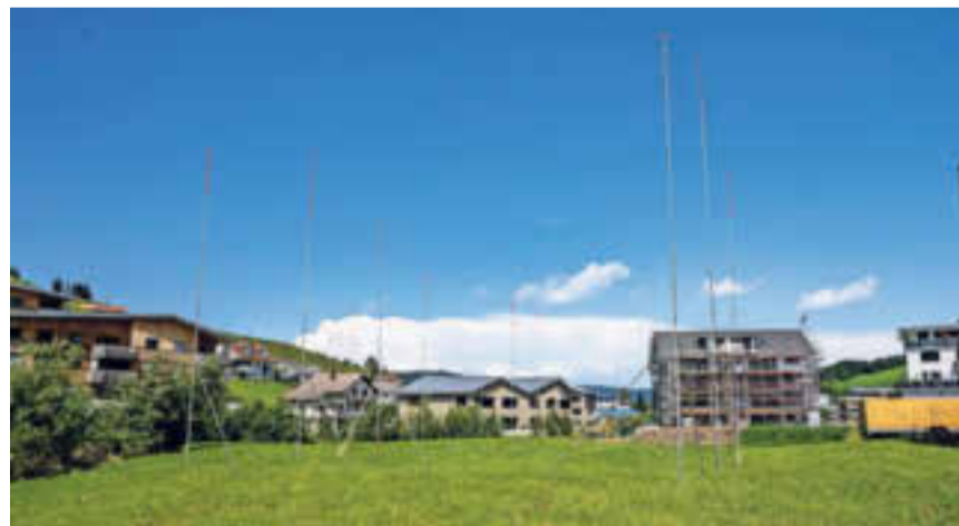
Auf dem Areal Rittlisgatter wird eine neue Bauetappe realisiert.
